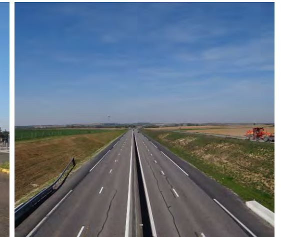
Photo 18 : A29 à proximité d'Ennemain (Source : BE JC)
