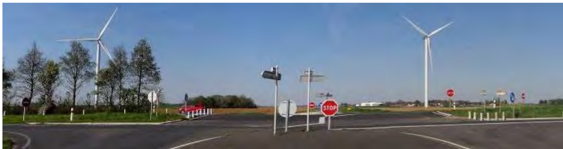
Photo 22 : Croisement D934 et D139 à proximité de Damery (Source : BE JC)
