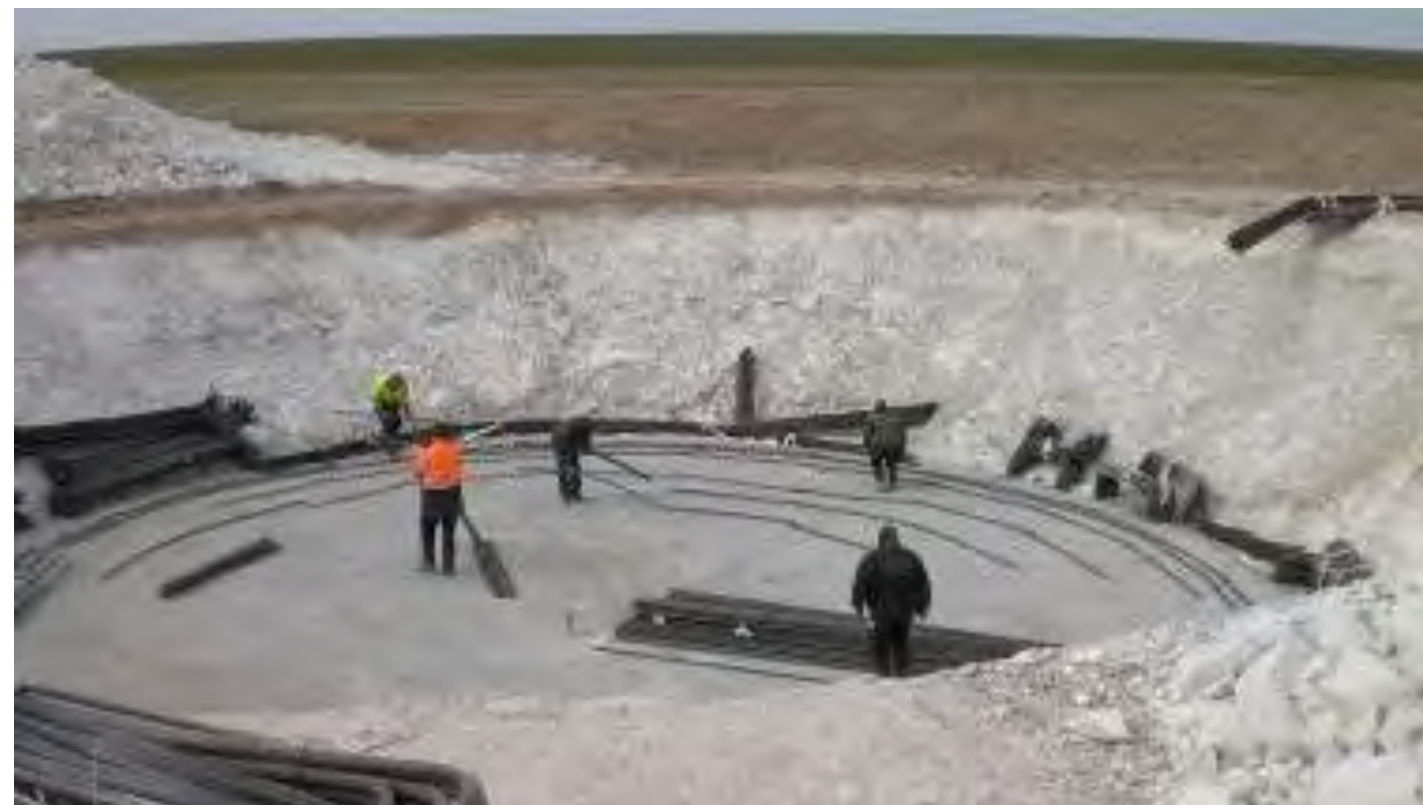
Photo 102 : Exemple de fondation à remettre en état
