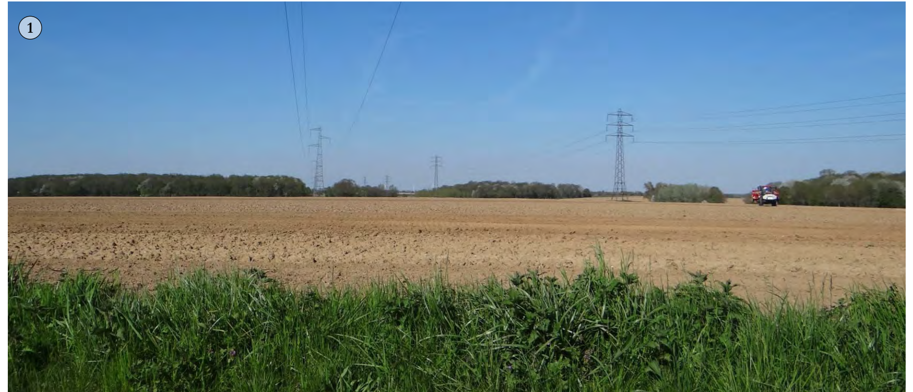
Photo 95 : Vue sur la ligne haute-tension passant le long de la zone du projet et sur les bois bordant la D139 (Source : BE JC)
