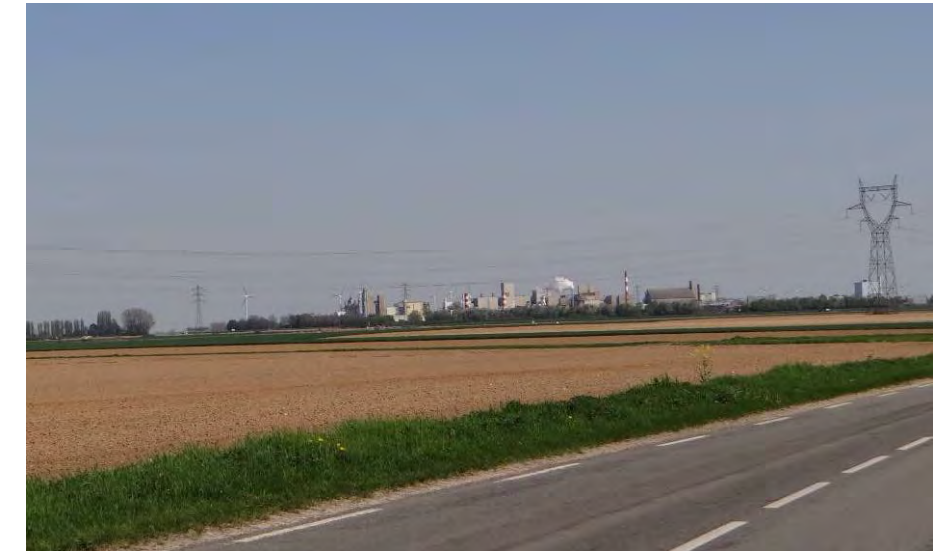
Photo 36 : Vue sur une usine à Nesle (Source : BE JC)
