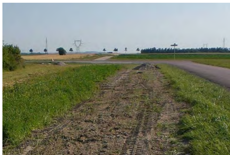
Photos 101 : Rebouchage de tranchée après passage des câbles électriques (Source : BE JC)
