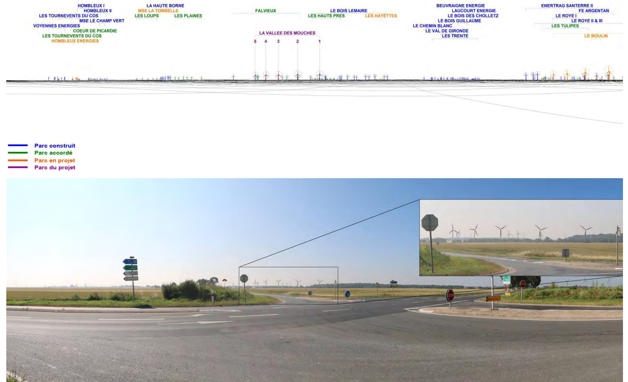
Figure 63 : Vue illustrative et photomontage 49 au croisement de la D1017 et de la D337 à 4 945 m du projet, angle de 120° (Source : BE JC)
