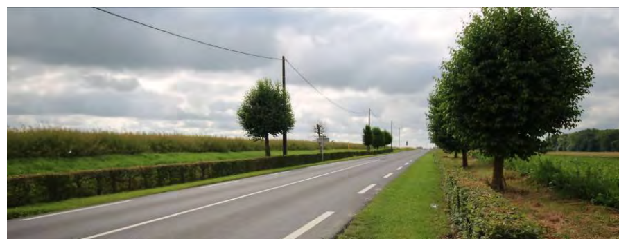
Photo 42 : D934 en sortie de Roiglise (Source : BE JC)
